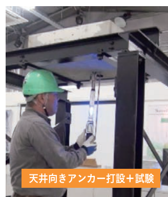
アンカー引張試験体験
